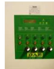
**Установки давления бустерной установки задаются на дисплее панели.**
